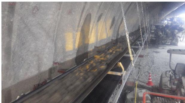
写真-6 ベルトコンベア運搬状況
