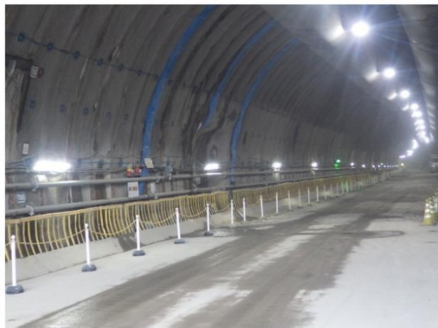
写真-8 トンネル坑内LED照明
