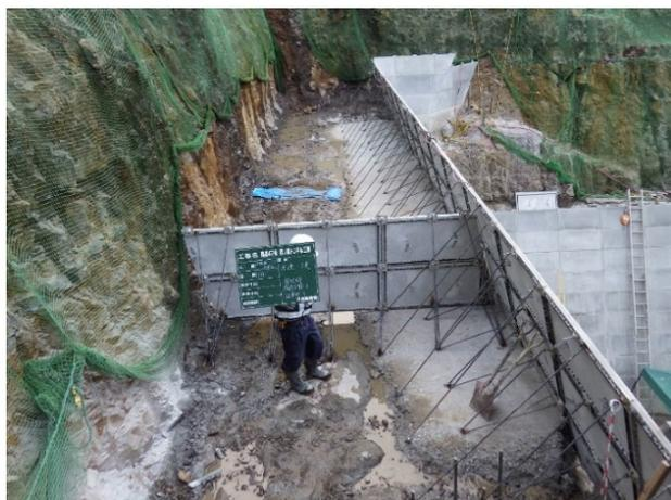
写真-3 埋設型枠組立状況
