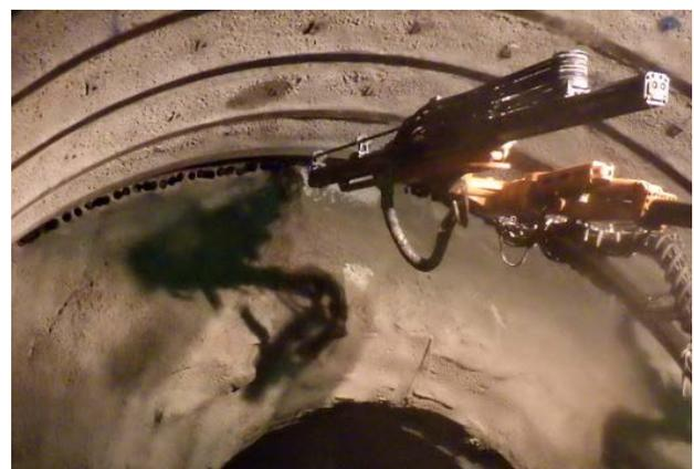
写真-11 スリット溝施工状況
